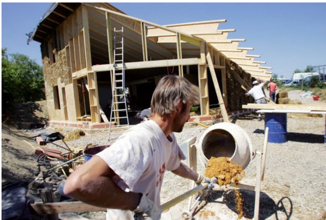
Chantier de construction d'une maison bioclimatique à Athée (Côte-d'Or) : des bottes de pailles servent d'isolant. ANDRÉ DURAND / AFP
